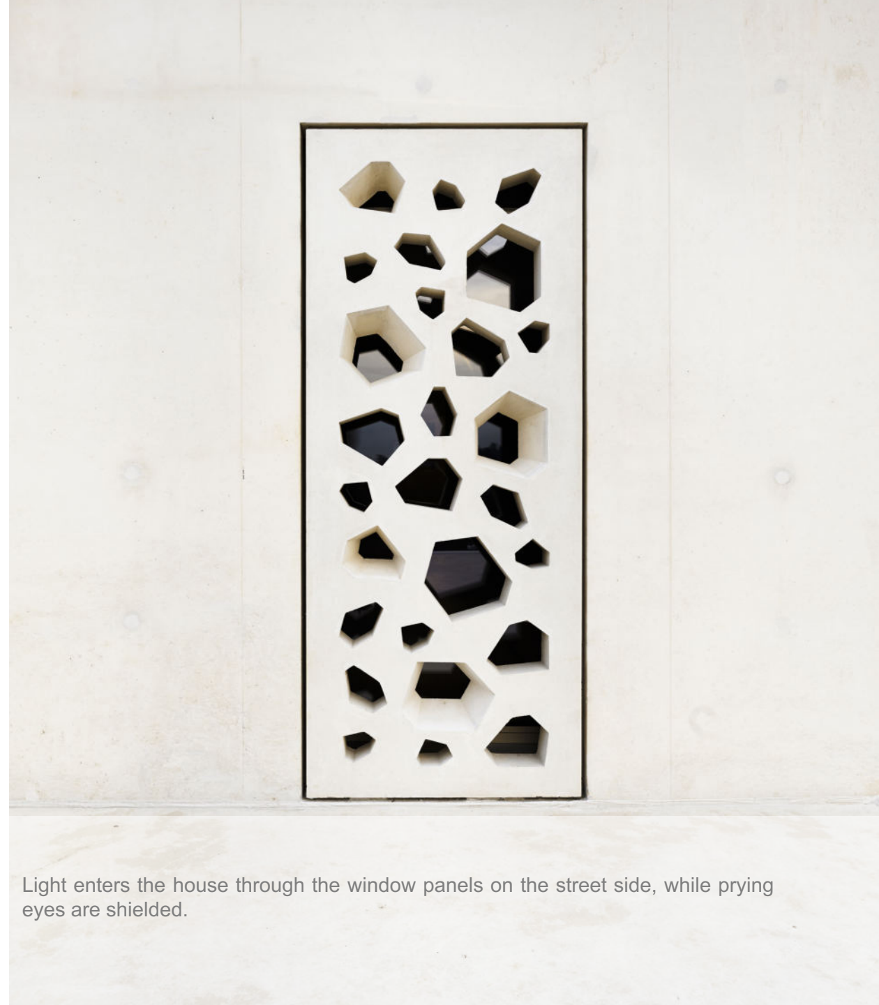
Licht gelangt durch die Sichtblenden zur Strassenseite ins Haus, während neugierige Blicke abgeschirmt werden.
